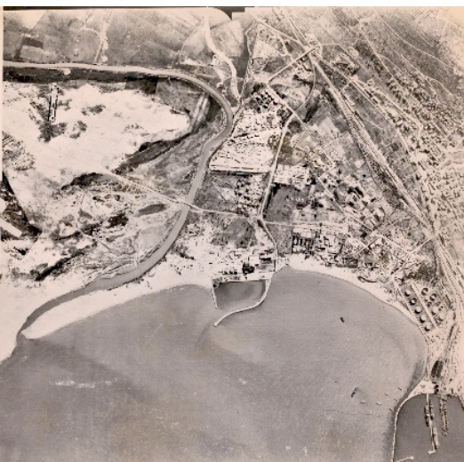
Photographie aérienne du site © service archives MOM
